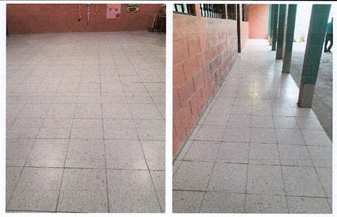
Rubro No. 6 Mejoramiento de piso
