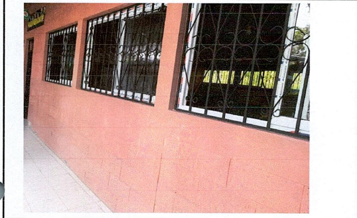
Rubro No. 5: Mejoramiento de Ventanas
